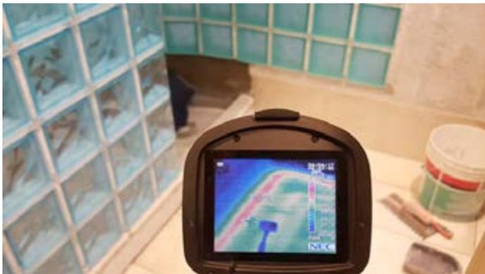
Le fughe tra le piastrelle possono essere stuccate dopo 12 ore con apposite stucature elastiche ed impermeabili.
