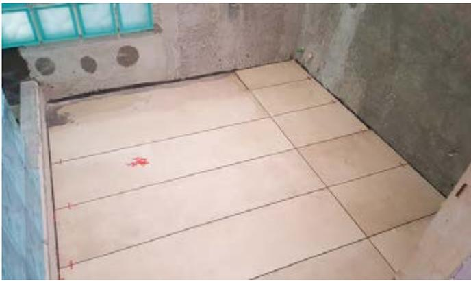
Per l'incollaggio diretto di ceramiche o materiali lapidei utilizzare colle poliuretatiche bicomponenti ed impermeabili tipo **Keralastic (Mapei)** o **Ultralite S2 Quick (Mapei)**.
