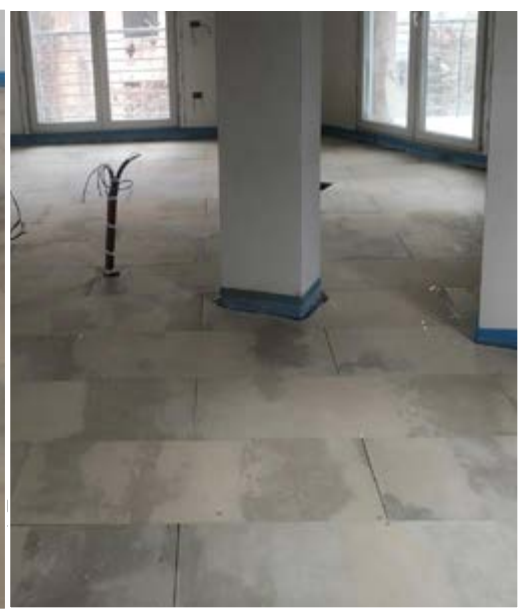
Posizionamento dei due strati di pannelli tipo BetonWood®tongue&groove per .es. in corrispondenza di pilastri.
